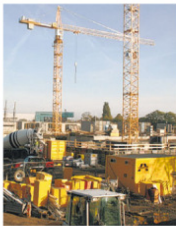
Noch eine Baustelle: So sieht die Schlossinsel derzeit aus.
